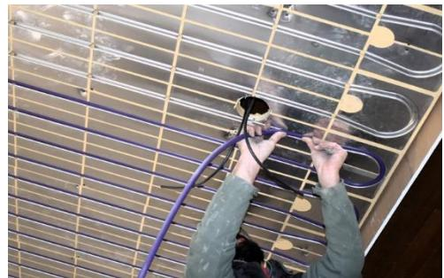
Prévu pour une installation en neuf comme en rénovation, le système complet, tubes et dalles, ne mesure **que 3 cm d'épaisseur** et offre la possibilité d'aménager aisément pièces de vie et combles. Totalement intégré au bâti, le plafond ACOSI+ fibre de bois **élimine le besoin de radiateurs ou d'unités de climatisation apparentes**. Sans circulation d'air, il contribue aussi à un intérieur plus sain, **limitant la dispersion de poussières, allergènes ou bactéries**.
