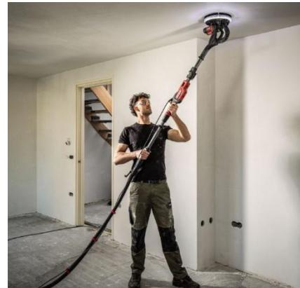
Idéale pour le ponçage des plaques de plâtre, des panneaux d'isolation ou toute préparation des supports avant peinture, la ponceuse à plâtre SKIL de **225 mm de diamètre** est équipée d'un **manche extensible jusqu'à 1,8 m**. Elle combine les meilleures technologies :
